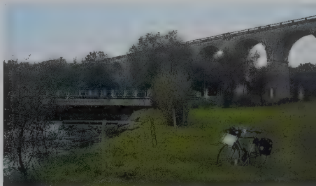
Spoorwegviaduct aan de Oise
