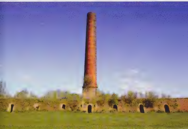
Van steenfabriek De Blauwe Kamer resteert de romp van de ringoven en een schoorsteen op halve lengte.
